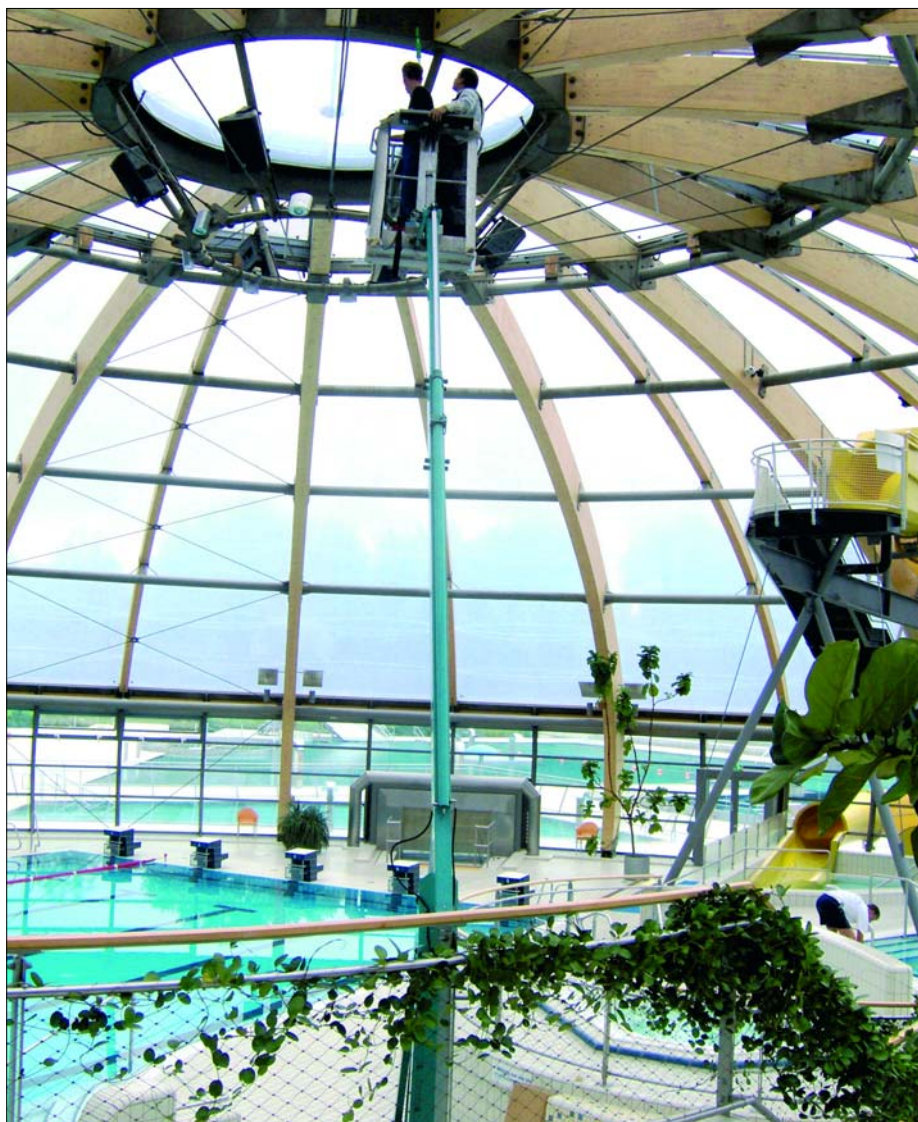
Hoch hinaus. Mit dem Hubsteiger begeben sich DREIECK-Mitarbeiter in die Kuppel des Johannisbades in Freiberg. In einer Sonderreinigung wird in dem sportlich orientierten Freizeitbad die Konstruktion aus Stahl und Holz gesäubert.
